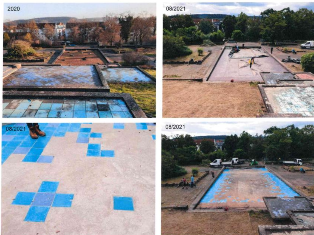
Abbildung 2: Rückbau der Wasserterrassen (Bauabschnitt 3A) – Teil I
